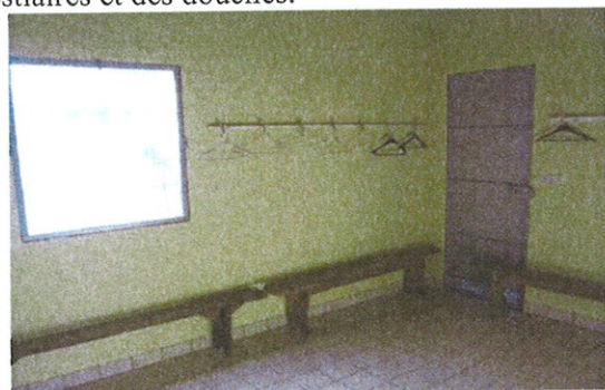
Les vestiaires rénovés du stade de la Rivière
