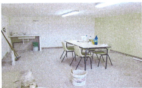
La salle «Alain DELAGNES» en cours de travaux
